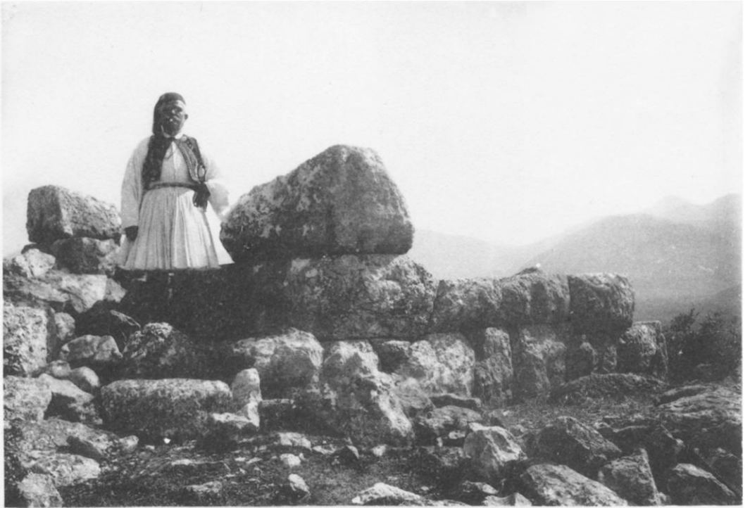
FIG. 1. TOWER ON MÝTIKA (ANCIENT SKOPÈ).
